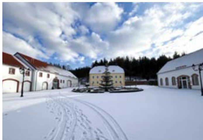
Gut Königsbruch im Januar 2024: Blick vom Tor in den Innenhof.
